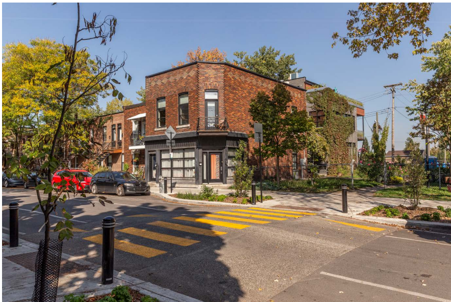
Passage surélevé pour piéton devant le parc Fernand-Gignac
