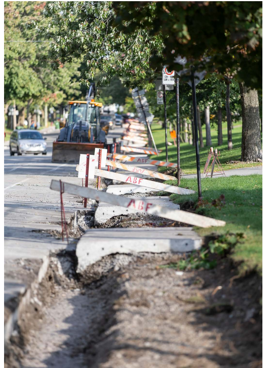
Travaux aux abords de l'école Sainte-Louise-de-Marillac
