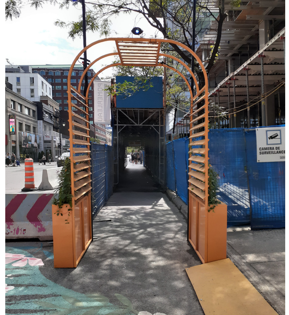
Aménagement piétonniers temporaires durant les travaux de construction Source : SNC-Lavalin
