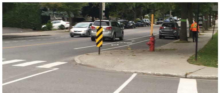
Saillie de trottoir permettant la continuité du cheminement cycliste, intersection de la rue Forbes et du boul. O'Brien, arrondissement Ahuntsic-Cartierville.
