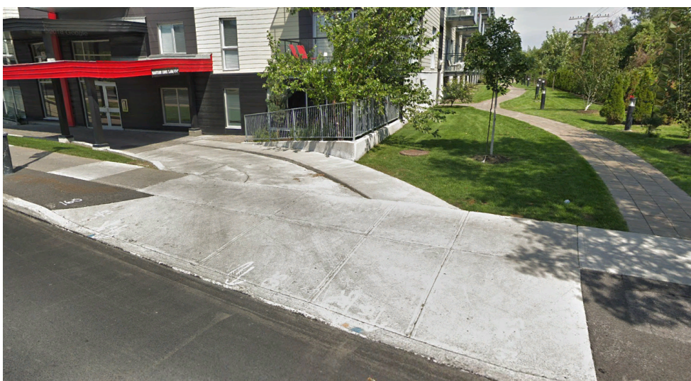
Exemple d'entrée charretière assurant la continuité du niveau du trottoir, avenue Papineau, arrondissement Ahuntsic-Cartierville
