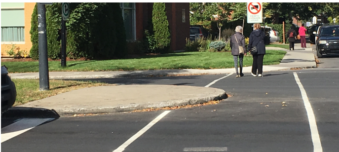
Terre-plein trop court, empiétant partiellement sur le passage piéton, ne bénéficiant pas de bateau pavé
