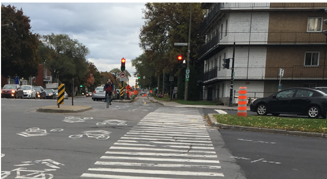
Exemple d’un refuge pour piétons au même niveau que la chaussée, intersection du boul. Henri-Bourassa et de l’avenue Christophe-Colomb, arrondissement Ahuntsic-Cartierville
