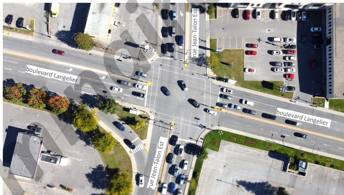
Vue aérienne du croisement du boulevard Langelier et de la rue Jean-Talon Est
