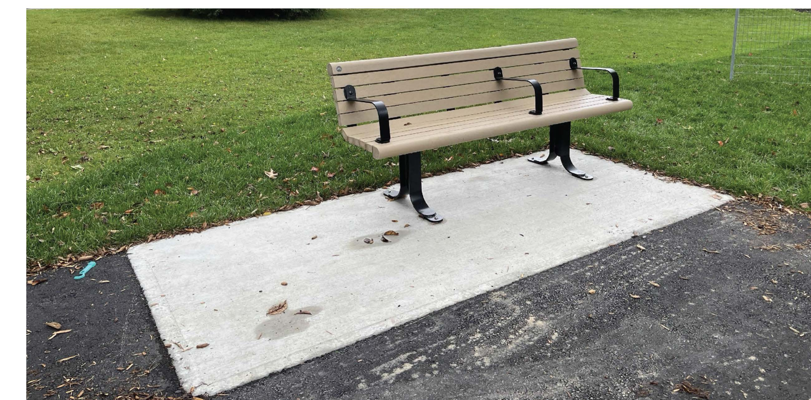
Accessible Bench + Concrete Pad Banc accessible sur dalle de béton
