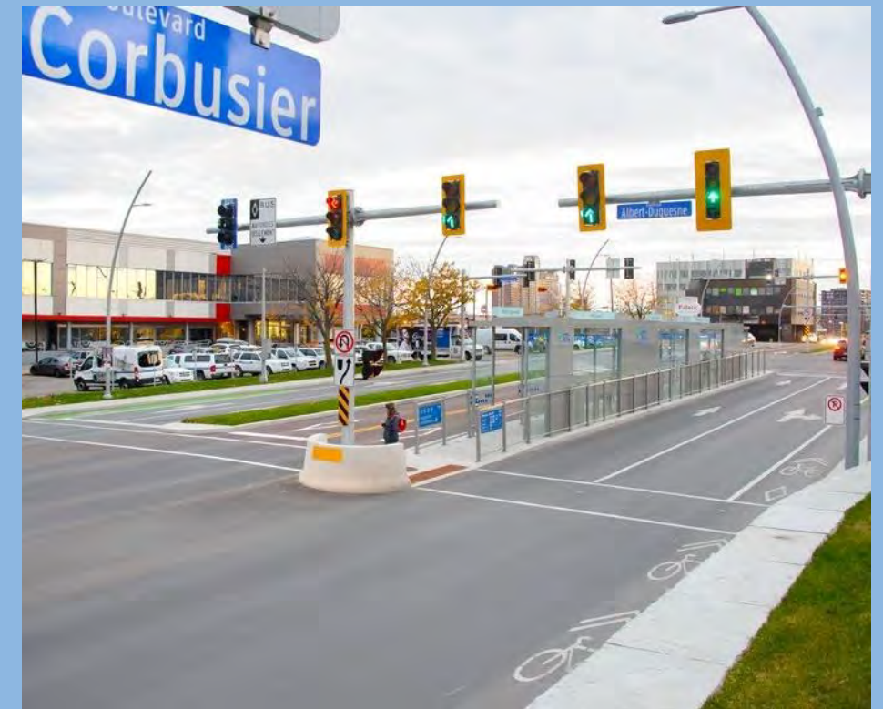
Photo 5.1.1f – Voies centrales réservées pour BHNS, Laval
