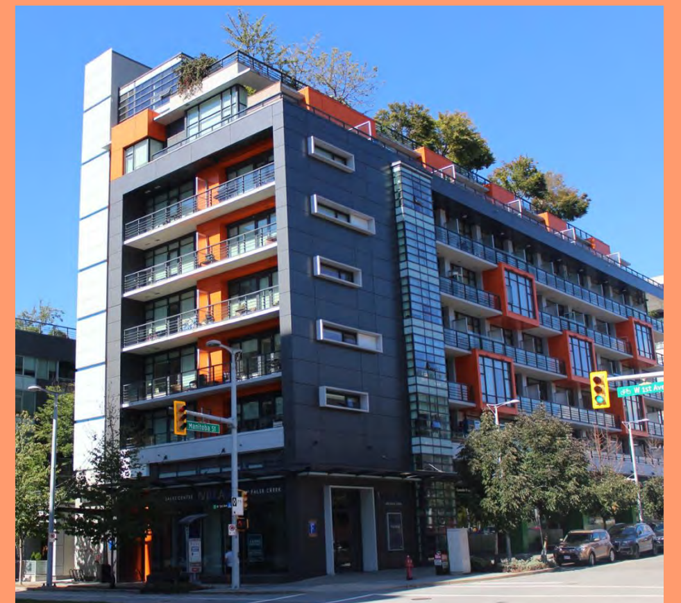
Photo 5.2.2u – Architecture contribuant à l'identité du secteur, Vancouver
