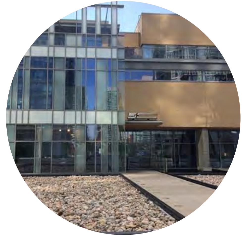
Photo 5.2.2aa – Bâtiments à bureaux dotés d'un parvis, Toronto
