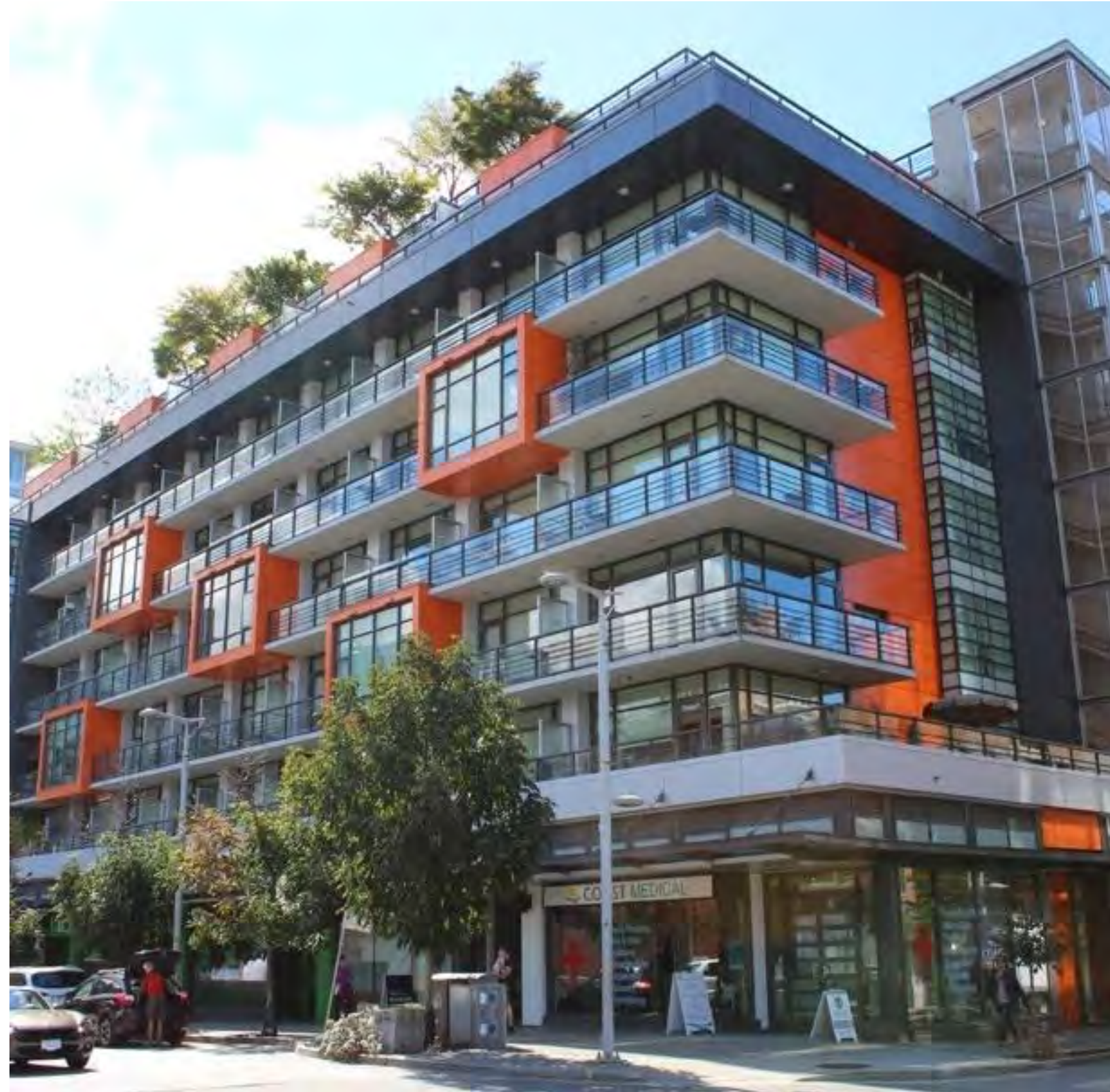
Photo 5.1.5c – Composition rythmée des façades et interaction du rez-de-chaussée avec l'espace public
