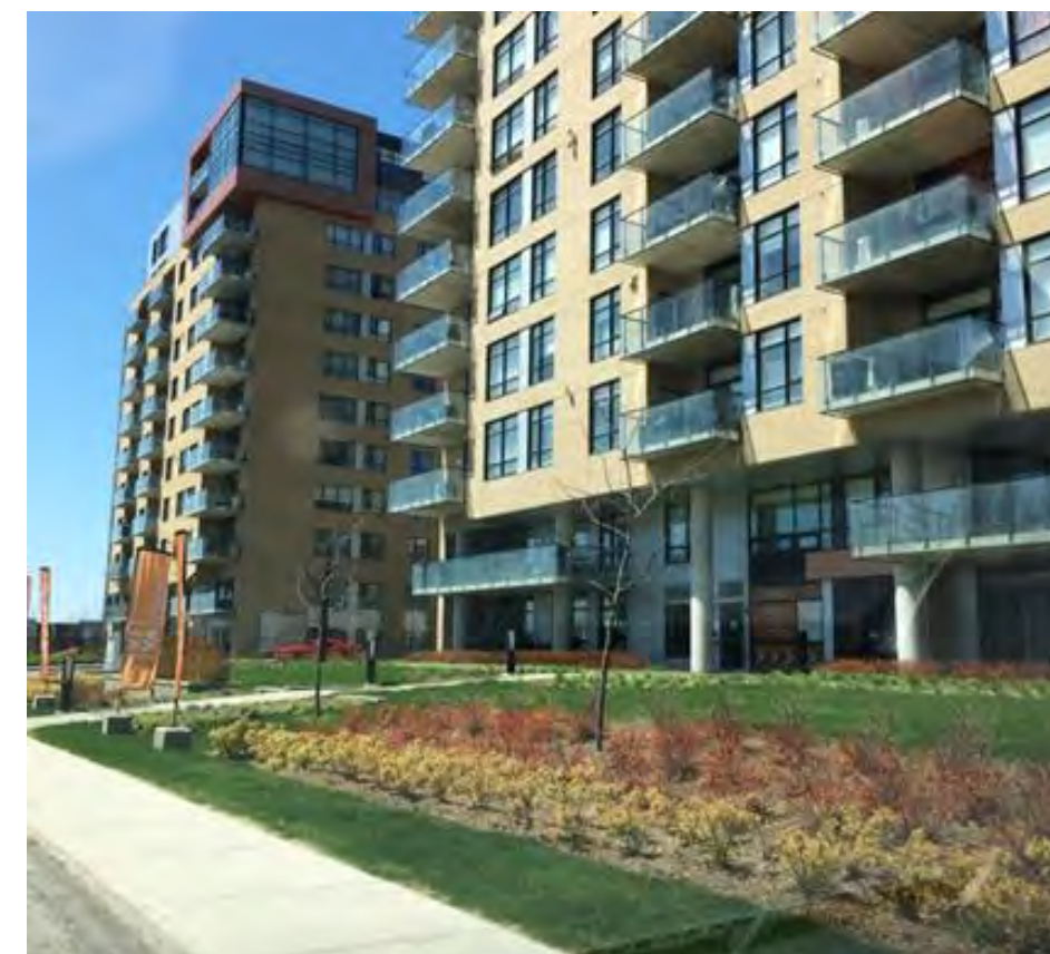
Photo 5.2.1p – Traitement du rez-de-chaussée résidentiel
