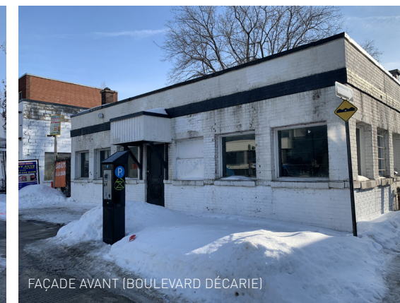
FAÇADE AVANT (BOULEVARD DÉCARIE)
