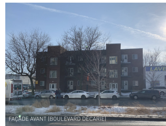
FAÇADE AVANT (BOULEVARD DÉCARIE)
