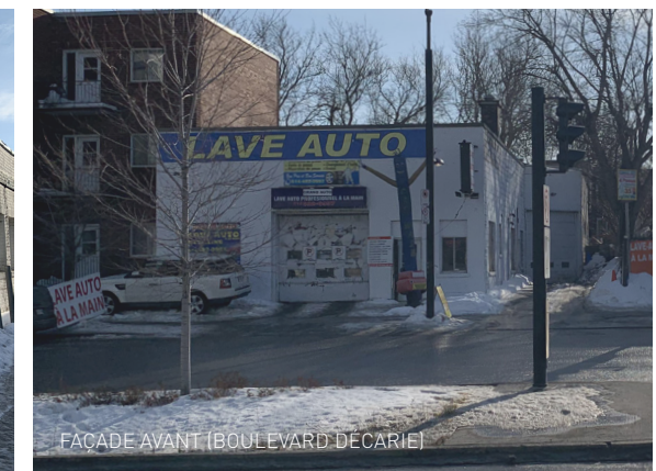
FAÇADE AVANT (BOULEVARD DÉCARIE)
