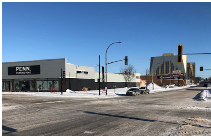
Bâtiment commercial avec façade aveugle situé sur la rue Jean-Talon
